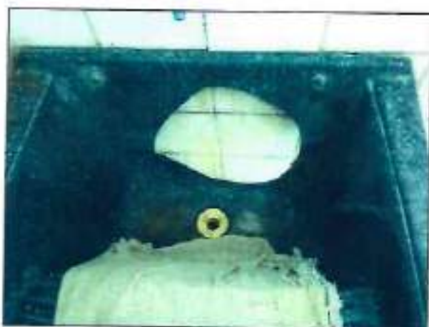
Imagem 35 – Tanque danificado.
