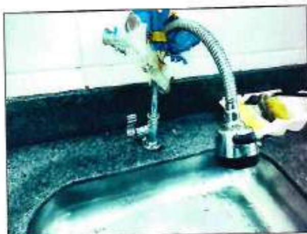
Imagem 15 – Torneira da cozinha.
