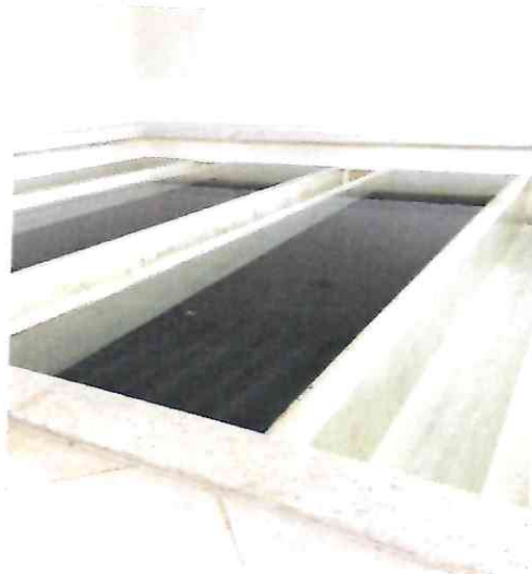
Decantadores em carga
