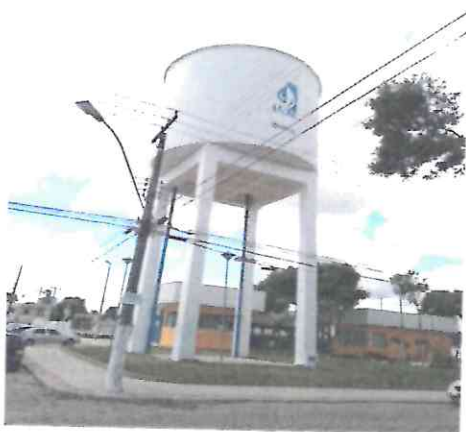
Reservatório Elevado - Shell
