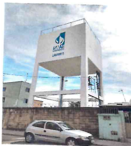
Reservatório Elevado - Linhares V
