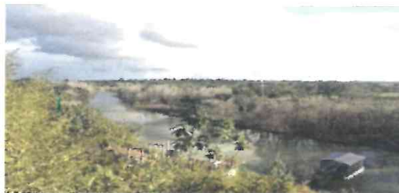
Captação de Água Rio Pequeno
