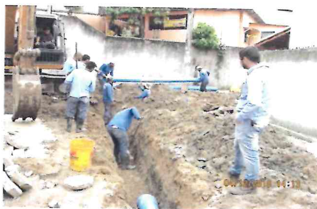
Execução de serviço de abastecimento de Água
