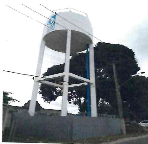
Reservatório Elevado - Canivete
