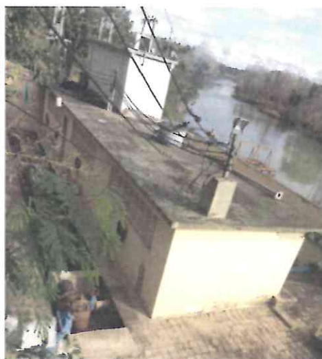
Captação de Água Bruta
