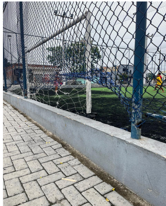
Manutenção na tela
