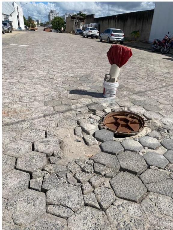
Conforme visita feita ao local há uma falha estrutural que representa deterioração da infraestrutura, podendo causar danos adicionais à estrutura da via, bem como risco à segurança pública, com o perigo iminente de acidentes envolvendo pedestres, ciclistas e
