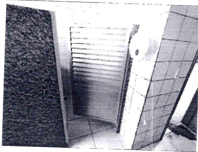
(Instalação de porta veneziana no banheiro)
