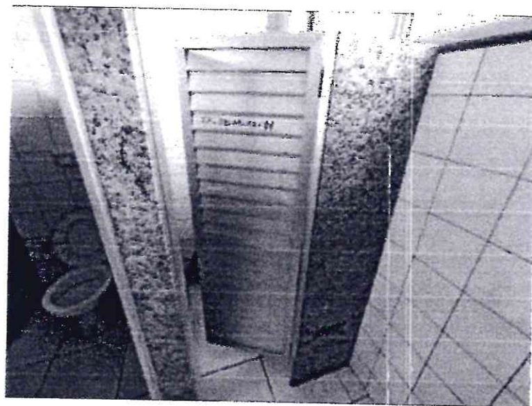
(Instalação de porta veneziana no banheiro)
