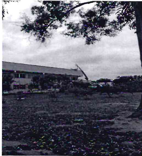
12/09/2022: troca das telhas
